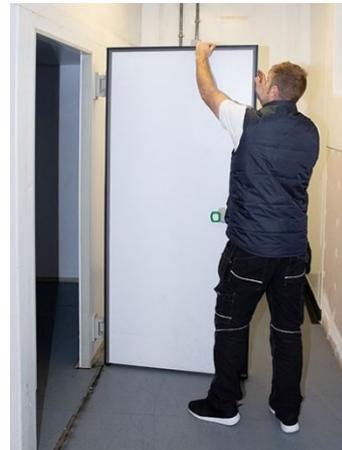
4 Fertigung vor Ort und sofortige Montage von Kühldichtungen an einem Tag
