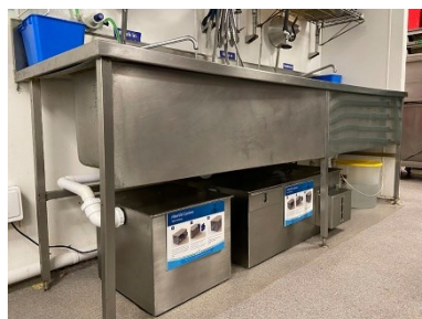
Fettabscheider „FiltaFOG Cyclone“ mit einem weiteren Gerät kombiniert
