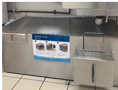
Fettabscheider „FiltaFOG Cyclone“
